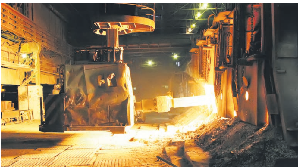
△ Первая загрузка печи после ремонта прошла успешно © АЛЕКСАНДР ЗАГРЕБИН
